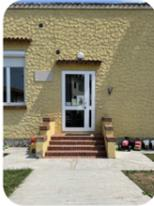
L'ingresso principale risulta sprovvisto di rampa d'accesso. **L'intervento di messa a norma non viene valutato in quanto già facente parte di un progetto di adeguamento esistente e presentato in regione FVG**
