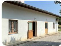
Si rileva la presenza di un dislivello superiore ai 3 cm tra marciapiede accessi all'edificio. Si prevede la creazione di un raccordo in cls, in corrispondenza dell'accesso alla sala comune.
