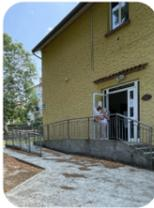
Si rileva che il parapetto della rampa esterna non presenta il corrimano ad altezza di 90 cm. Se ne prevede l'aggiunta.
