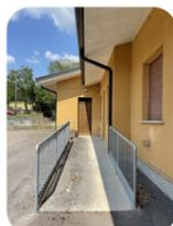
Si rileva che il parapetto della rampa esterna non presenta il corrimano ad altezza di 90 cm. Se ne prevede l'aggiunta.
