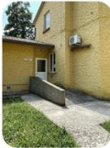
Si rileva che la rampa esterna risulta non a norma sia a causa della sua eccessiva pendenza che dal punto di vista del parapetto, privo di corrimano regolamentare. Si propone la sua demolizione e sostituzione con rampa metallica prefabbricata.
