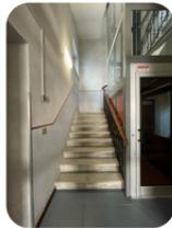
I gradini della scala di accesso ai piani superiori risultano privi di segnaletica cromatica per ipovedenti e di antiscivolo. Si rileva inoltre l'assenza del corrimano ad altezza 90 cm, da un lato.
