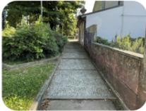
In adiacenza al prospetto della Sala Polifunzionale si rileva la presenza di un percorso con alcuni gradini di altezza variabile (fino a 4-5 cm). Si prescrive l'eliminazione dei gradini e la realizzazione di una rampa.
