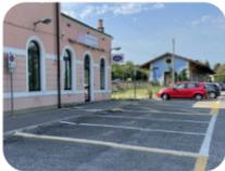
In corrispondenza del parcheggio disabili manca una rampa di raccordo tra la quota del piazzale e quella del marciapiede. Si prescrive la realizzazione di tale raccordo e inserimento di sistemi loges.
