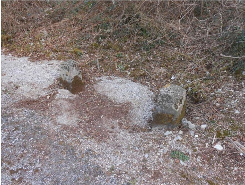
**Foto 8. L'opera di regimazione idrica a bordo strada completamente intasata**
