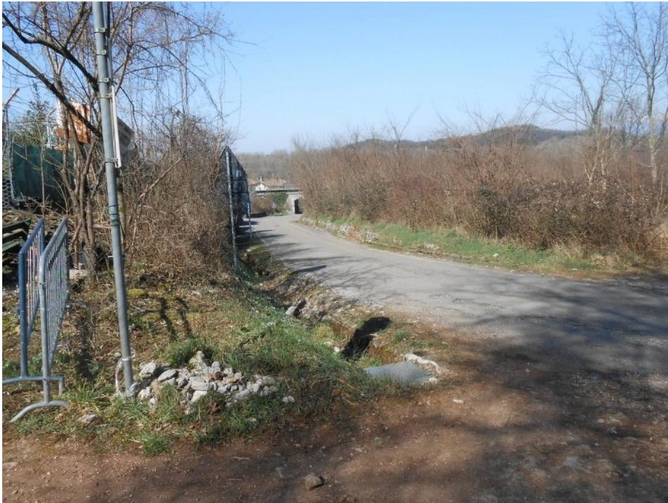
**Foto 17. In caso di intensa precipitazione le acque divagano lungo l'asse stradale**
